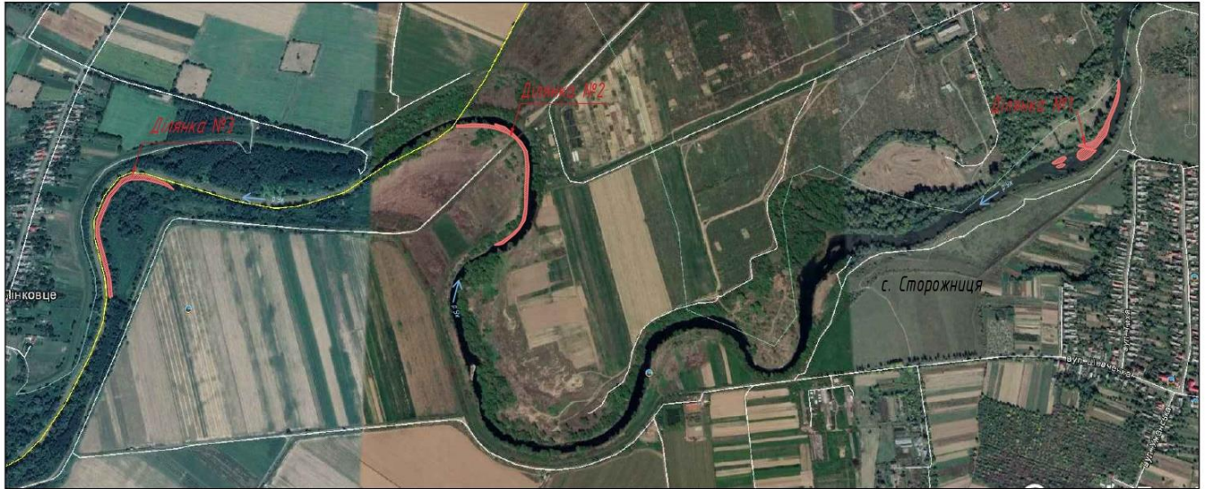
Ділянки проведення робіт, с.Сторожниця, р.Уж
